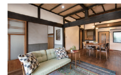
仏間を造作。解体時に現れた梁を出し天井高を以前より高く取りました。以前はエアコンが取り付けられず、夏は暑く、冬は寒い状態。リノベーション後はエアコンを取り付け、客間としても趣味部屋としても快適に過ごせる空間となりました。
