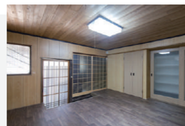
和室2間を仕切る建具を取り除き、一続きの10帖のリビングダイニングが誕生。床を貼り替え、壁は漆喰壁としました。天井はガマ芯仕上げとなっています。
