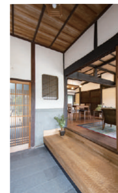
式台の高さを下げ、上り下りしやすくなった玄関。ヨーロッパアンティーク無垢フローリングをオープンカットで仕上げた式台。
