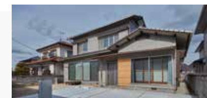
外壁を塗装し直し、新築同然となった外観。塀や樹木を撤去し、広々とした駐車場とお庭が誕生しました。
