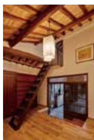
土間の物置だったスペースは、玄関ホールにし、上り下りしやすいよう床を改修しました。あまり使っていなかった2階の物置は、元々あった階段を再利用し、屋根裏部屋として再生させています。
