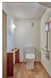
トイレは、将来的に車いすでも出入りがしやすいよう通常の1.5倍のスペースを確保しました。床には、無垢材を使用し以前に比べ使い勝手も格段に向上しました。
