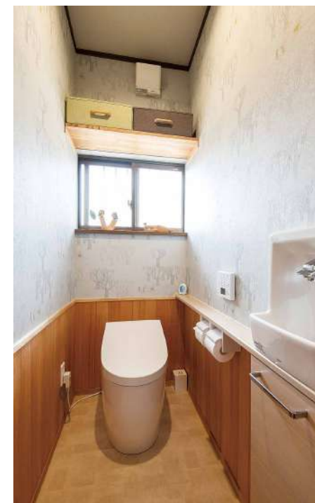
配置は変更せず、建具を片開きからスライディングドアという省スペースで開閉ができるものを採用。内装にも腰壁に羽目板を取り入れナチュラルな雰囲気になりました。
